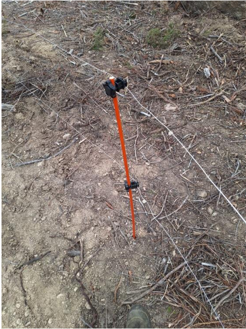
Instalación de valla
